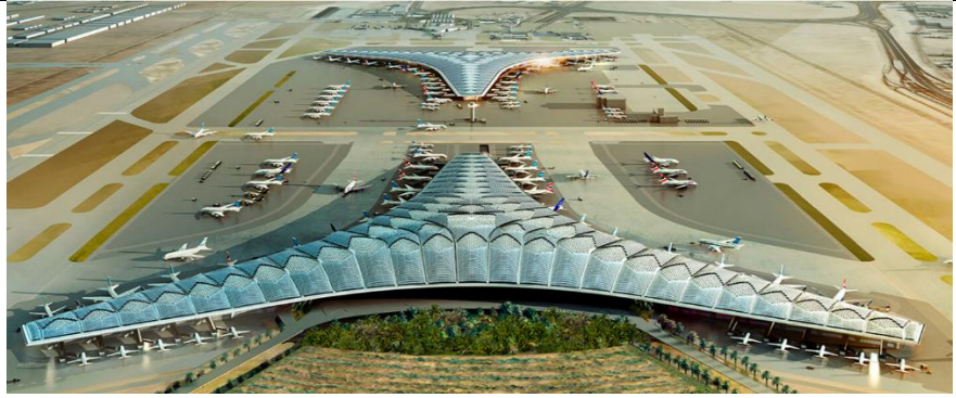
图表 55: 科威特国际机场二号航站楼
